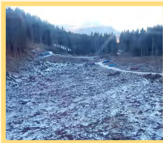
Il disboscamento a Frataces per fare spazio al futuro lago
